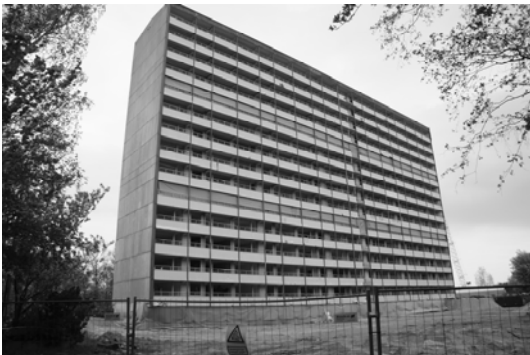
Bygning på Agerkær.
